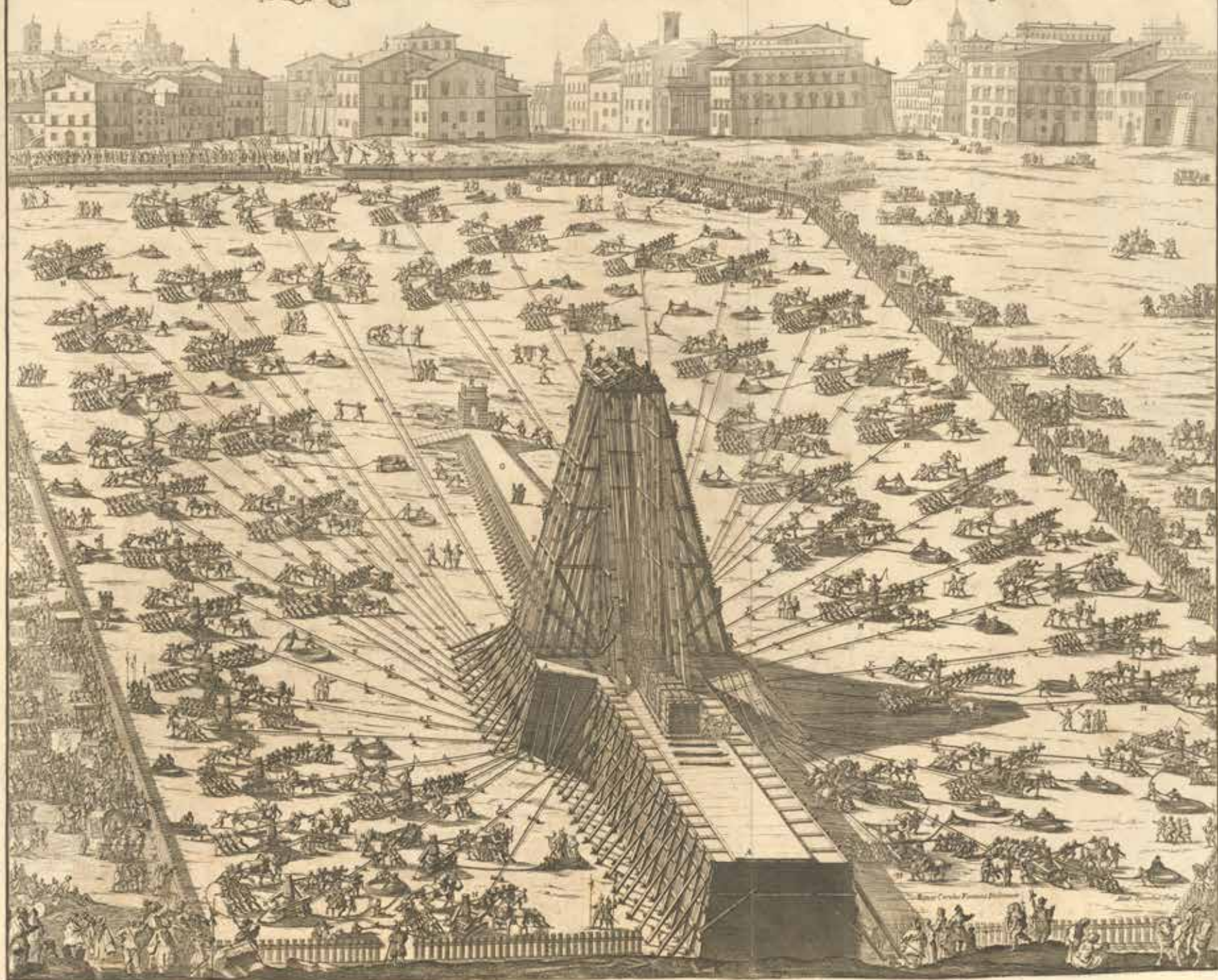
DISPOSIZIONE E VEDUTA GENERALE DELLE MACHINE CHE SERVIRONO PER ALZARE L'OBELISCO VATICANO.
