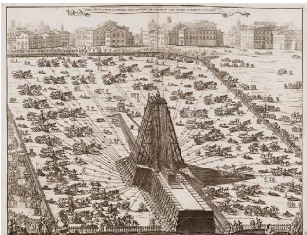
Disposizione e veduta generale delle machine che servirono per alzare l'obelisco vaticano in "Castelli e ponti di maestro Nicola Zabaglia con alcune ingegnose pratiche, e con la descrizione del trasporto dell'obelisco Vaticano e di altri", 1743 (Fondo antico, colloc. EAS XVIII 2° (in folio) 08)
